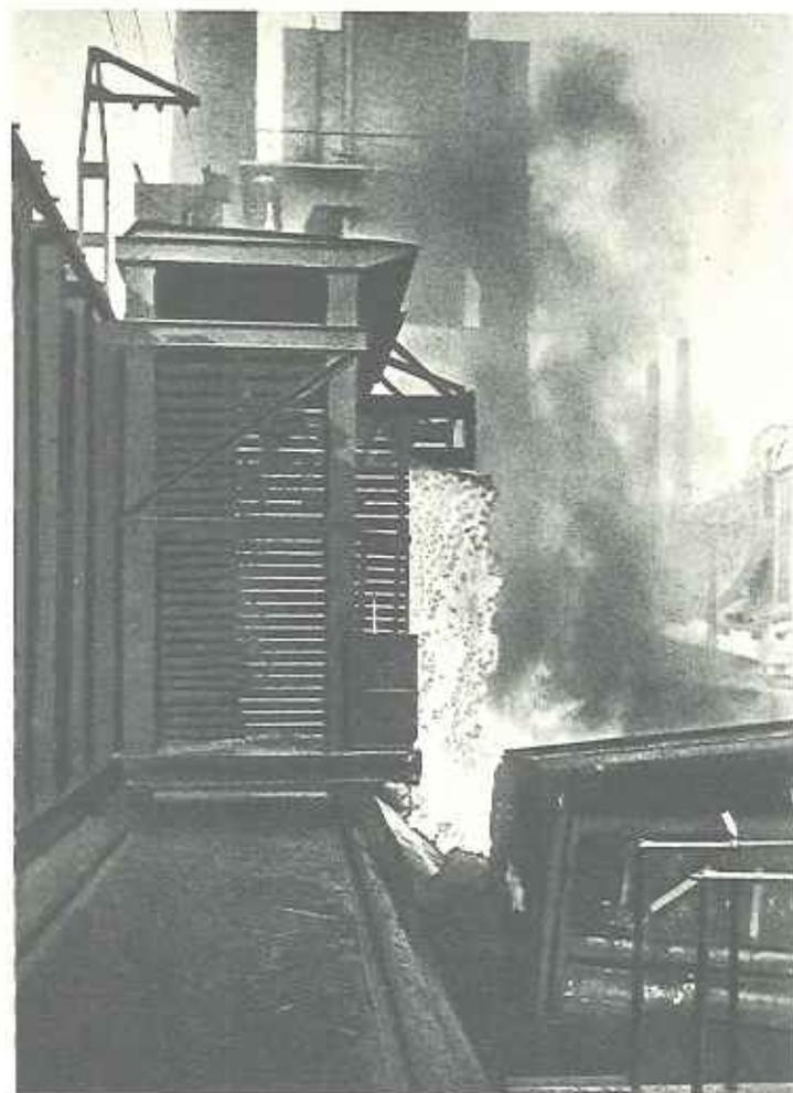
Si "storna" da una batteria di forni a coke.
